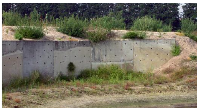
Plaques de béton posées à Veenendal, aux Pays-Bas (Bachmann et al., 2008)
